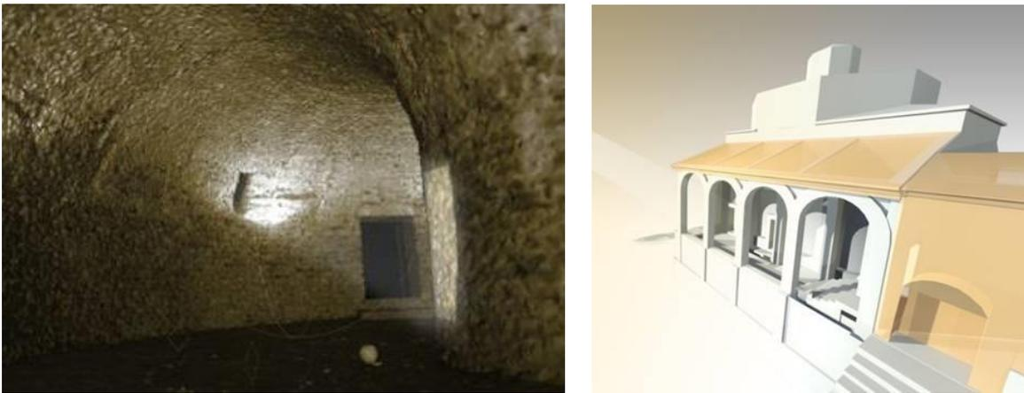
Figure 36 : Simulation de l'éclairage de la crypte du Pessebre de l'abbaye de Cuxa : la présence d'ouvertures dans les parois sud de la crypte a justifié la restitution d'une galerie ouverte au niveau supérieur (Léonard Gugi © laboratoire MAP (UMR 3495 CNRS/MCC), 2011).
